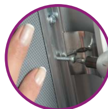
Fijación con tornillería oculta en el marco
